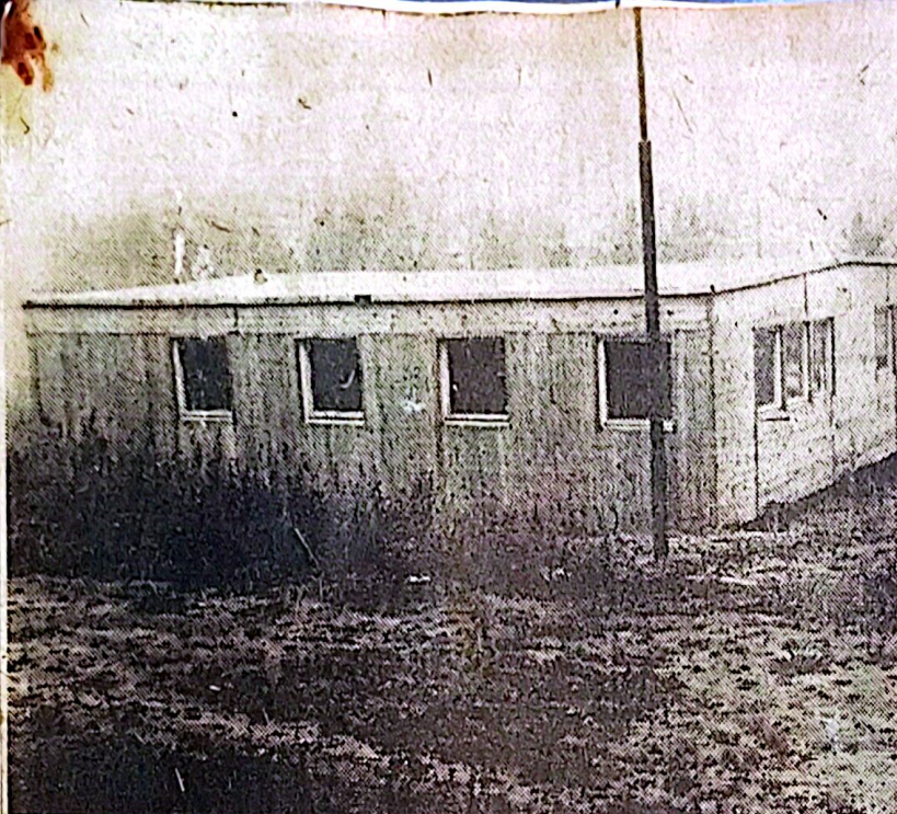
Ta „stodola” to część przyszłego obiektu rekreacyjno-wypoczynkowego budowanego przez SKR w Lubieniu Kujawskim... Fot. Jerzy KRYSIAK
