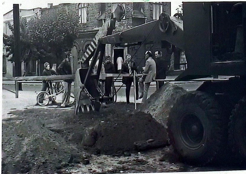
Mechanizacja wstąpiła na budowę nowego parilonu.
